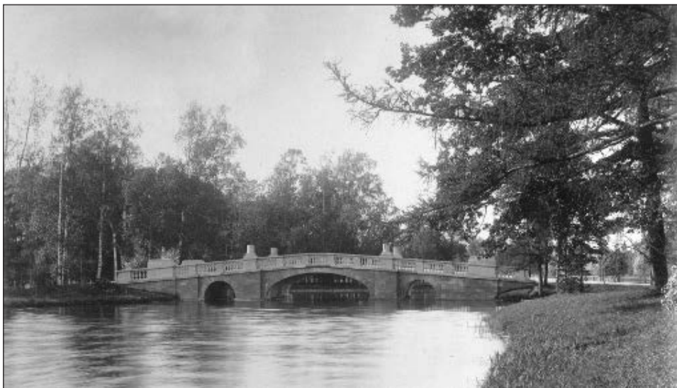
Большой каменный мост. Источник gatchinapalace.ru
