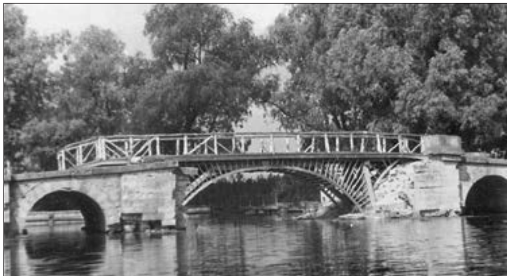
Большой каменный мост. Источник gatchinapalace.ru
